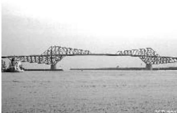
この橋は、年々増加するコンテナ輸送の道路混雑を緩和するため2004年から建設されました。橋の下を大型船が運航できるよう三角形をつなぎあわせたような独特の形状（トラス橋）が特徴です。中央防波堤と若洲地区を結び、全長は2618メートルであるレインボーブリッジの約3倍（海上を跨ぐ区間の長さは1,618mで約2倍）もあります。
